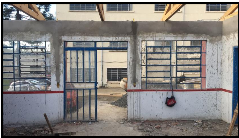
17.05.2018 - Fiscalização da Obra – Casa dos Conselhos – CAM.
